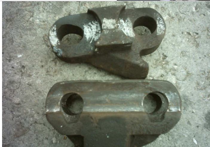
Фиг.1 Пресевна Plasser - Износени отвори на звена и зъби на верига ЛЕПЖИ гр.Плевен/.
